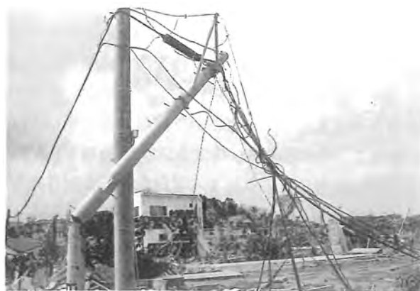
写真3 電柱の倒壊（宮城・気仙沼）
