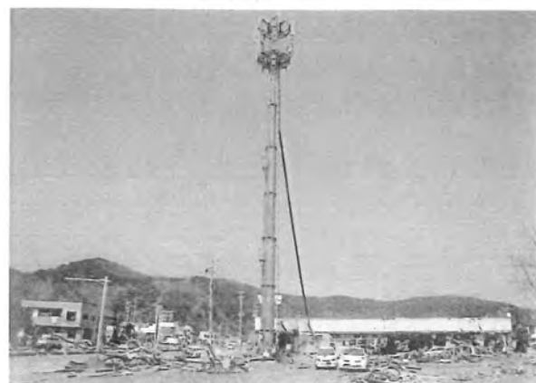
写真4 携帯電話基地局の損壊
